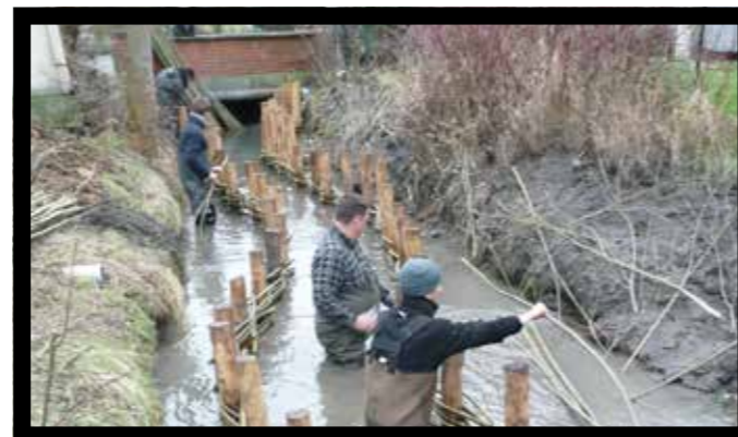
Technicien de rivière (renforcement des berges à Airaines)
