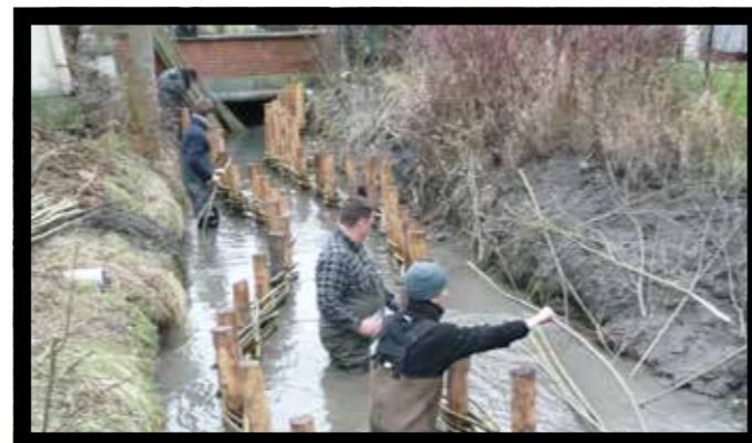
Technicien de rivière (renforcement des berges à Airaines)
