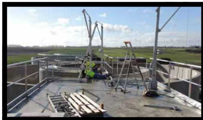
Agent de station d'épuration (chantier d'Urvilliers)
