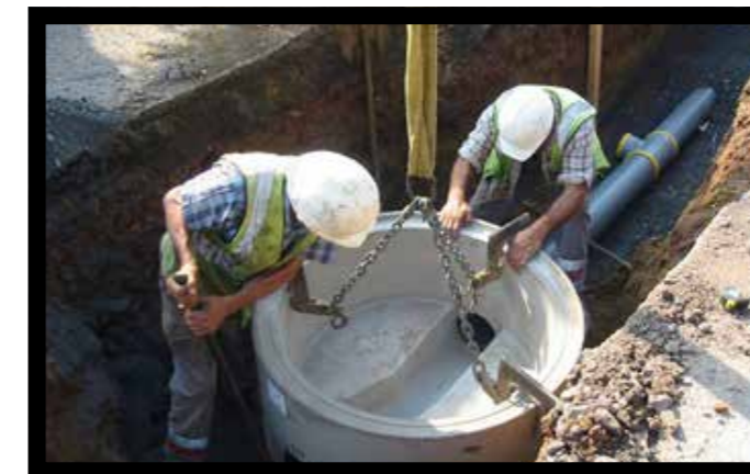
Pose de réseau d'assainissement en tranchée ouverte classique (mise en place d'un regard de visite)
