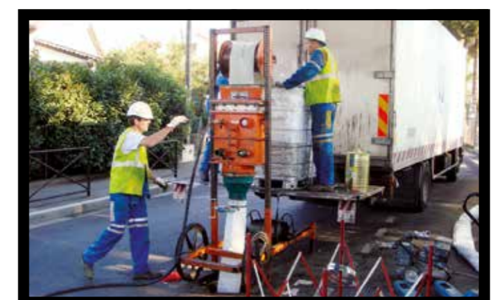
Réalisation d'un chemisage de canalisation existante
