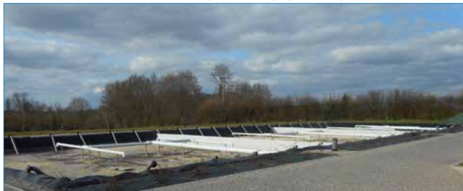
▲ Premier étage de traitement
