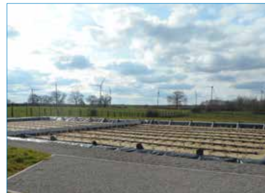
▲ Deuxième étage (filtre de sable)
