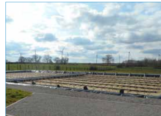
▲ Deuxième étage (filtre de sable)
