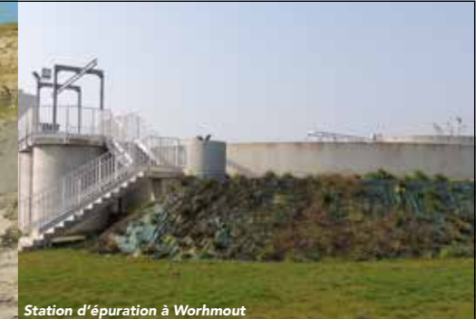
Station d'épuration à Worhmout
