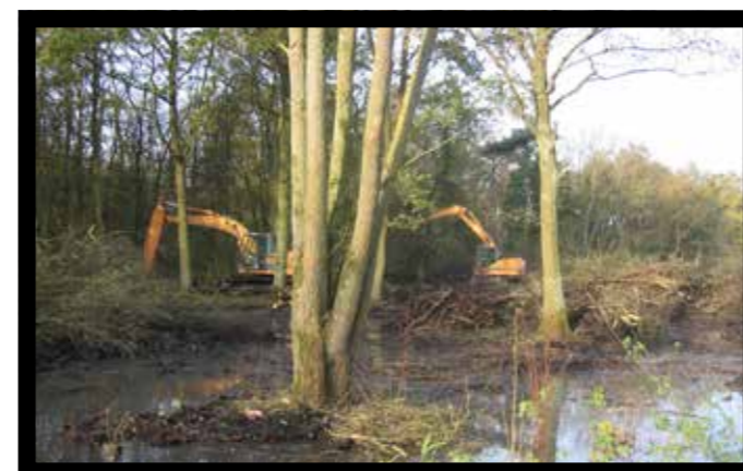
Aménagement de la presqu'île sur le site de l'étang d'Amaury
