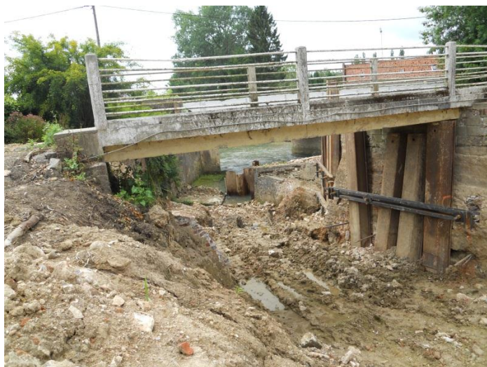
Terrassements avant fondations (SM pour le SAGE de la Canche)
