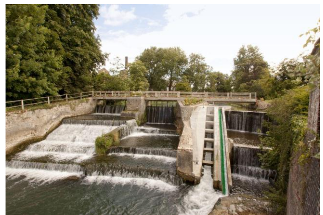
Le barrage après travaux (Agence de l'Eau)
