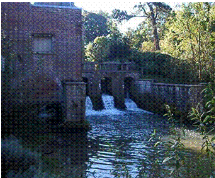
Barrage sur la Ternoise (Hericourt) (Agence de l'Eau)
