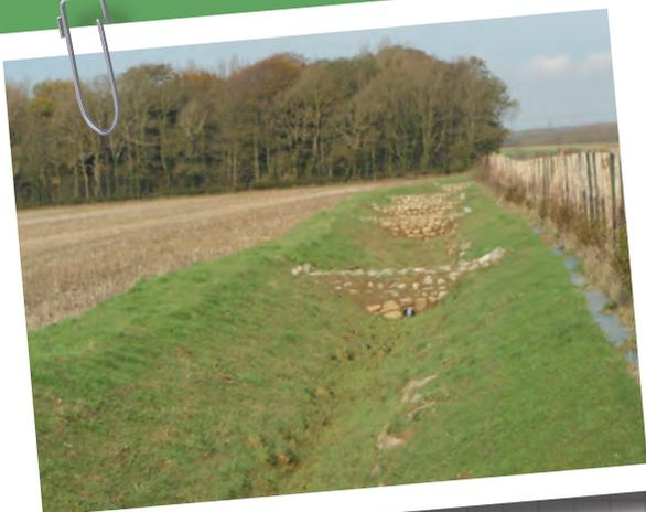
**Le rôle principal du fossé est de collecter et guider les eaux de ruissellement afin d'éviter la formation de ravine. Les eaux sont orientées vers des zones adaptées : un lieu de stockage et/ou d'infiltration.**
