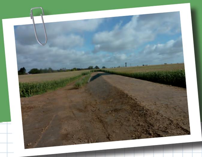
**La digue et la zone de rétention des ruissellements (ZRR) sont deux ouvrages complémentaires. La digue sert à former la ZRR. Elle permet de retenir temporairement un grand volume d'eau et favorise son infiltration. Lors d'événements exceptionnels, c'est un ouvrage de protection des biens et des personnes.**
