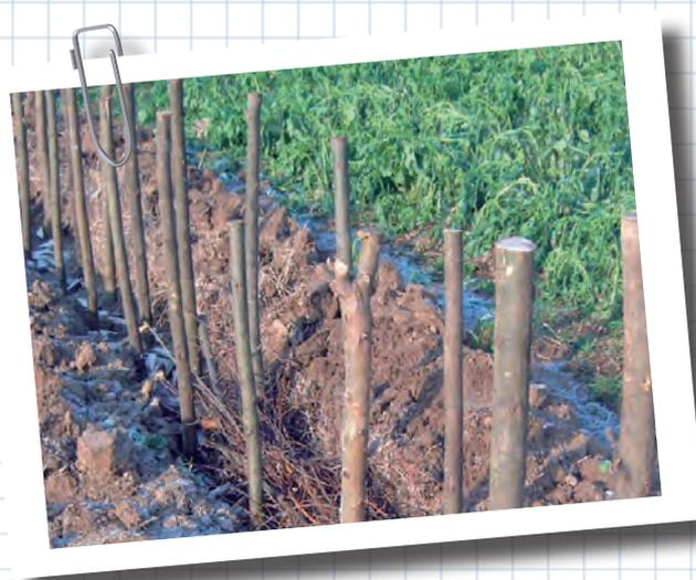
Il faut réaliser un joint de terre à la base de la fascine pour que l'eau ne crée pas de circuits préférentiels.
