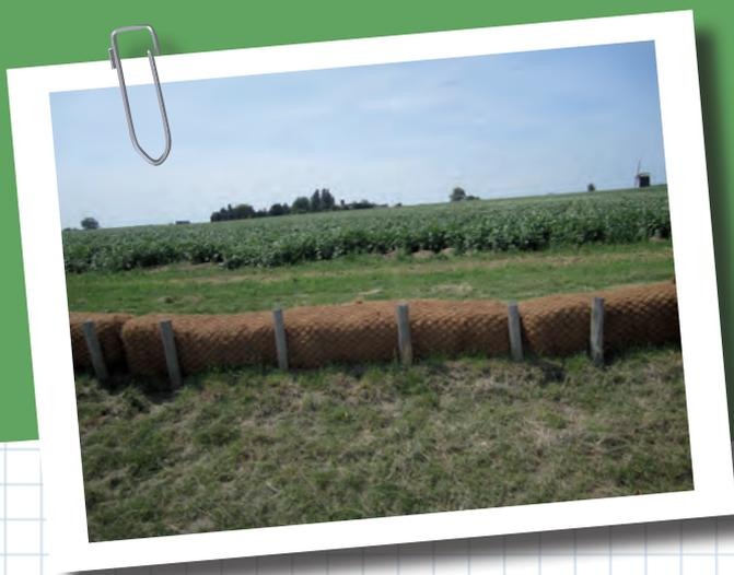
Les diguettes végétales sont des aménagements d'hydraulique douce qui filtrent et servent de barrage lors de phénomènes de ruissellements concentrés et de coulées boueuses. Elles sont des alternatives aux fascines vivantes dans les terrains drainés.
