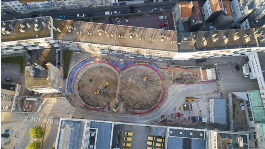
Le bassin de pollution de la Place de France d'une capacité de 12600 m<sup>3</sup> va contribuer à réduire de 90% les déversements d'eaux usées par temps de pluie et par conséquent permettre d'améliorer la qualité des eaux de baignade dès sa mise en service prévue en 2019.
