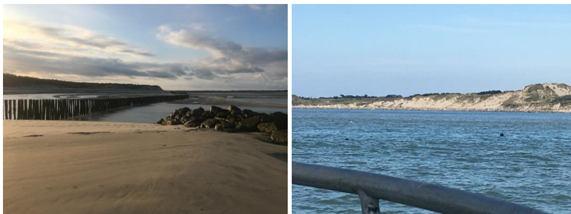
Photo 1 & 2 : Aménagements de protection (à gauche) contre l'érosion des dunes de la Baie d'Authie (à droite), les pieux et digues immergés à pleine mer ne sont pas visibles, ni marqués ce qui rend la navigation et le chalutage dans cette zone très risqué.
