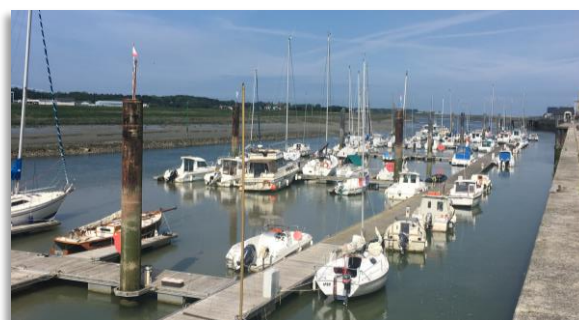
Photo 16 : La Canche aménagée, aérodrome du Touquet en rive sud, port d'Etaples en rive nord et digues submersibles
