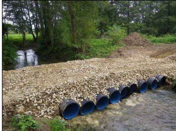
**Figure 85 : Illustration d'un ouvrage provisoire de franchissement de cours d'eau**
