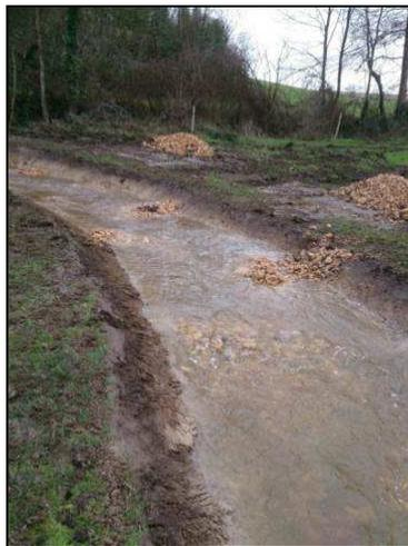
**Figure 99 : Vue d'une recharge granulométrique avec dépôt grossier de façon à créer des profils en travers irréguliers**
