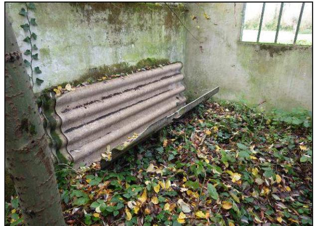
Figure 89 : Plaques fibrociment amiantées à évacuer
