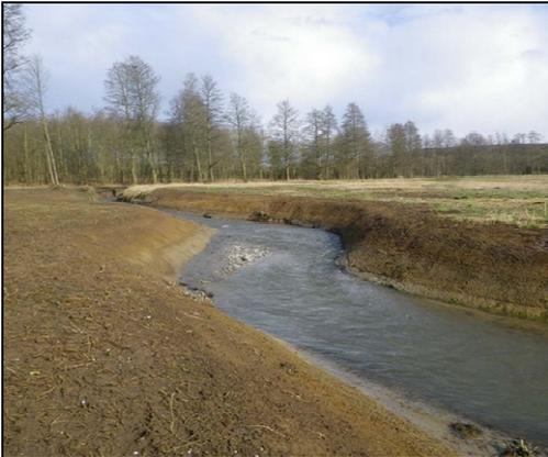
**Figure 103 : Illustration d'un nouveau tracé de cours d'eau juste après les travaux**
