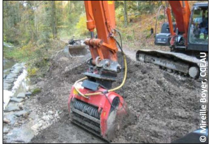
Figure 101 : Illustration d'un concassage/criblage de terres colonisées par les renouées asiatiques
