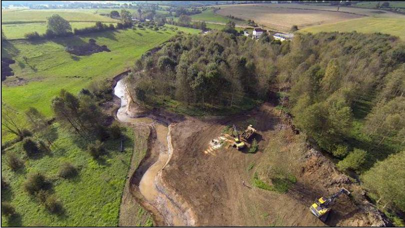
Figure 93 : Vue du ciel d'un reméandrage de cours d'eau
