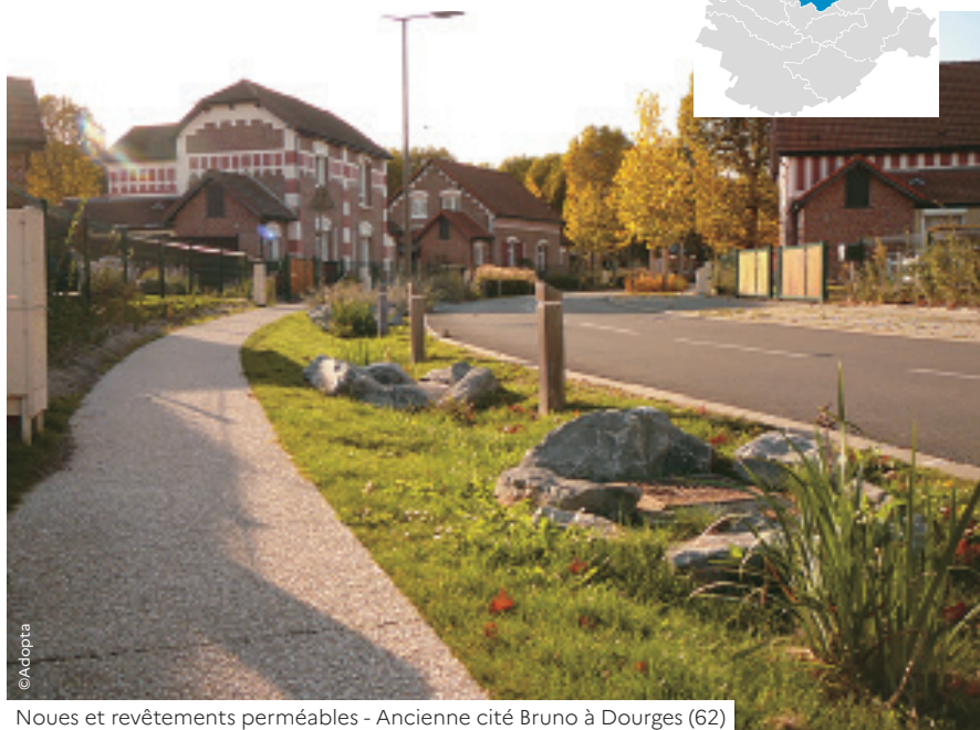
Noues et revêtements perméables - Ancienne cité Bruno à Douges (62)
