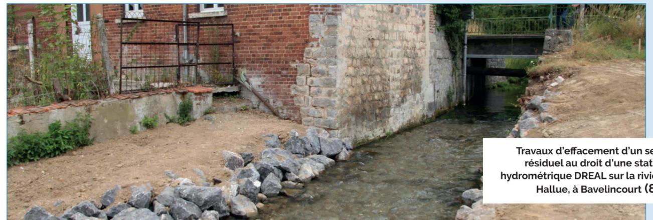
Travaux d'effacement d'un seuil résiduel au droit d'une station hydrométrique DREAL sur la rivière Hallue, à Bavelincourt (80)
