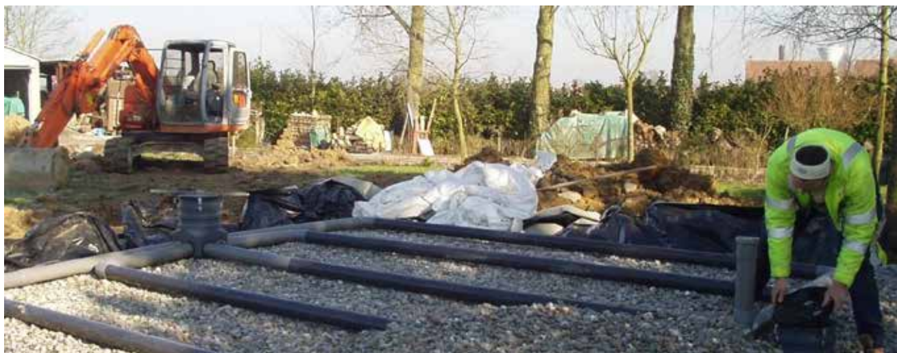
Travaux d'installation d'un dispositif d'assainissement non collectif
