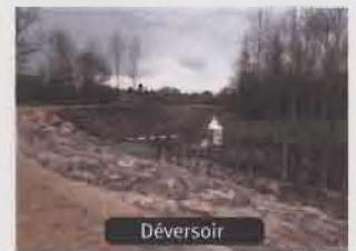
Le champ d'inondation contrôlée est alimenté lors des crues du cours d'eau par une simple prise d'eau aménagée dans la berge. Le fossé traverse le site et l'eau ressort par un système passif, un tuyau d'évacuation. Lorsque le débit de ce tuyau est inférieur à l'apport d'eau en crue, l'eau commence à se stocker. Pendant la crue, seul le périmètre inclus dans le site – la zone de sur-inondation – voit le niveau d'eau monter plus haut qu'au même endroit à l'état naturel, avant aménagement.
