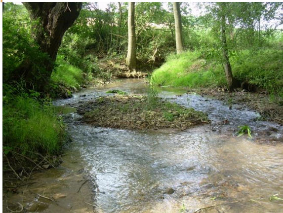
Barrage sur la Créquoise après travaux- AEAP
