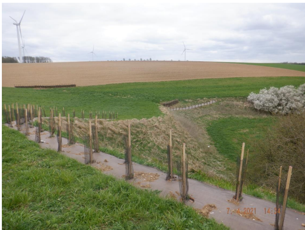
Aménagement de technique anti ruissellement à Fauquembergues H.CANLER - AEAP
