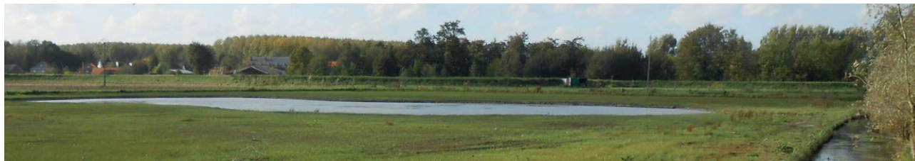
Zone d'expansion de crues à Gonnehem – AEAP
