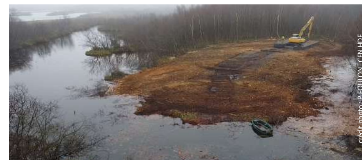
Intervention au marais des Quarantes sur la commune de Mareuil Caubert
