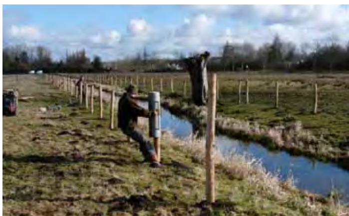
Pose de clôture (Crédit photographique : AMEVA)
