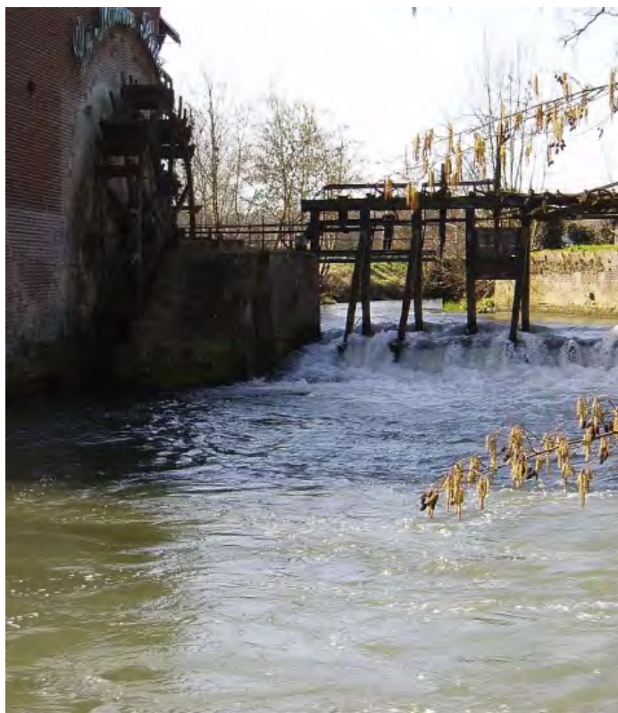
Moulin Snick avant travaux (Crédit photo : SmageAa)
