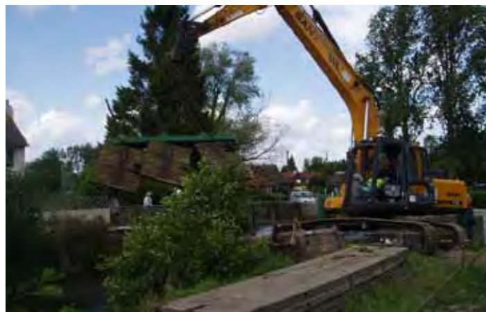
Figure 3 : démontage des vannages de l'ancienne pisciculture de Merck-Saint-Liévin (Crédit photographique : SmageAa)
