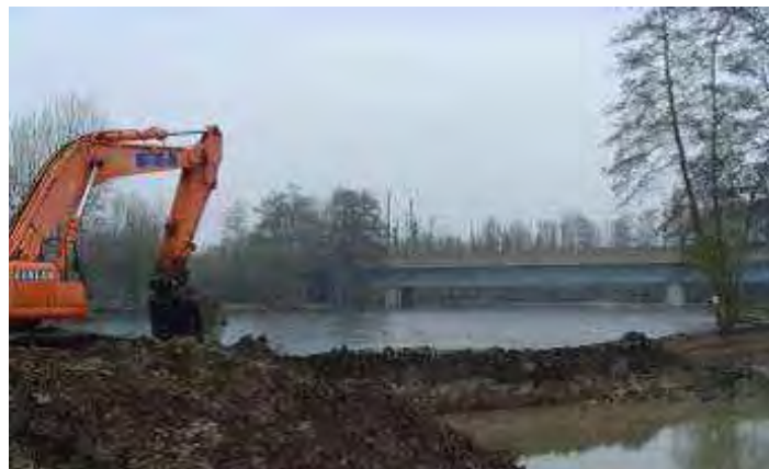
Mise en place de deux connexions hydrauliques entre la Scarpe canalisée et la frayère aménagée. Dispositif permettant la gestion des niveaux d'eau de la frayère
