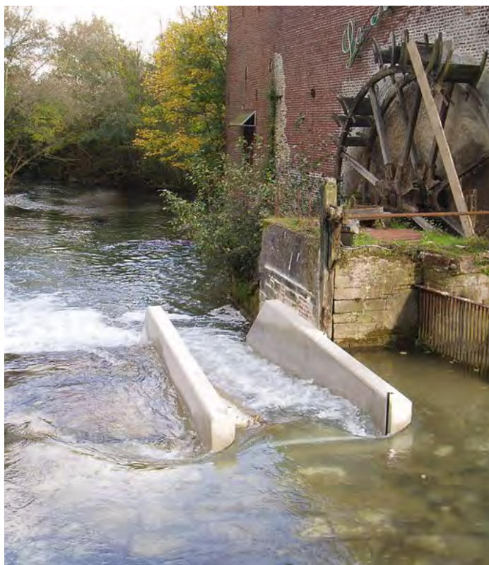
Moulin Snick après travaux (Crédit photo : SmageAa)
