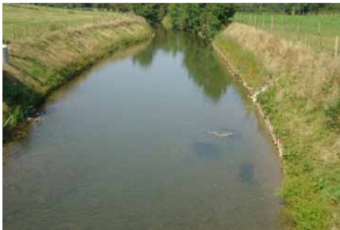
Berges stabilisées et végétalisées (2012- AEAP)
