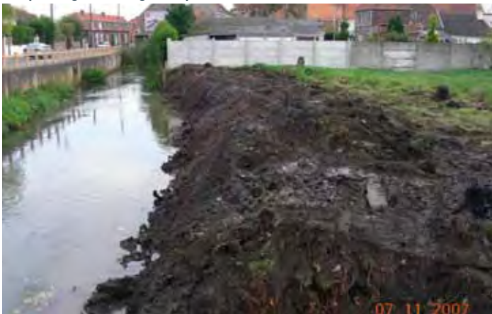
Retalutage des berges (Crédit photographique : Artois Comm)
