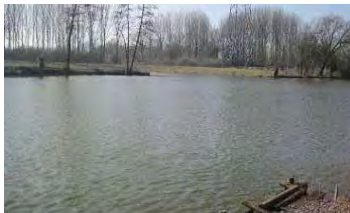
Creusement pour restaurer les liaisons hydrauliques des mares et fossés
