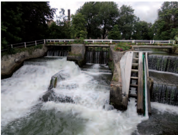
Passe à poisson à Auchy-lès-Hesdin
