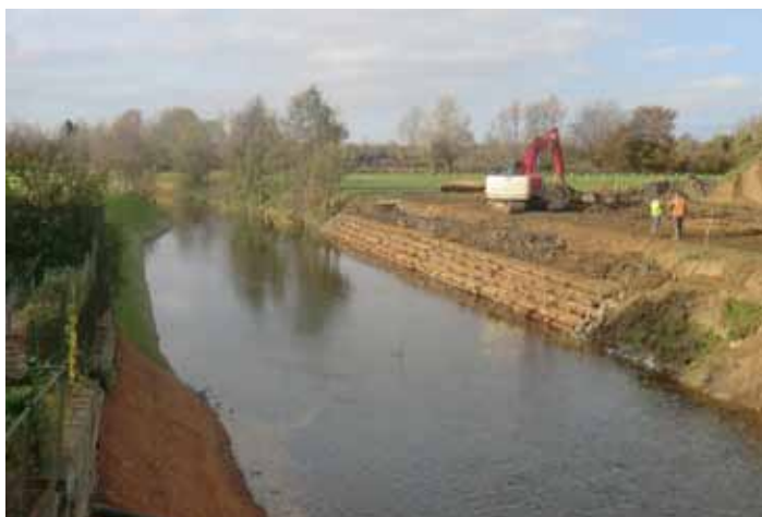
Site en travaux (Source : DREAL)
