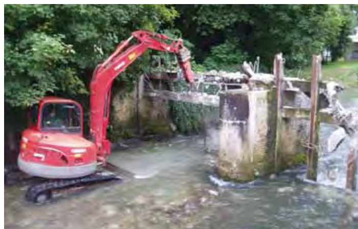
Figure 2 : démontage de l'ancien vannage de la SILL à Wizernes (Crédit photographique : SmageAa)
