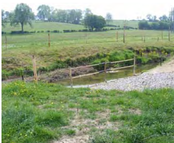
Installation de peignes pour diversifier les écoulements
