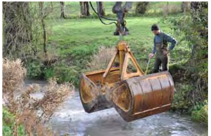
Recharge granulométrique en cours (crédit photo : FDAAPPMA 59)
