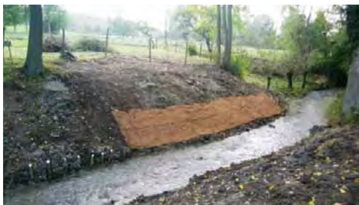
Pose de géotextile (Crédit photographique : FDAAPPMA 62)
