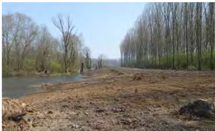
Abattage de peupliers et reprofilage des berges
