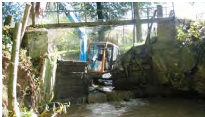
Démantèlement de l'ancien ouvrage (Crédit photographique : FDAAPPMA 62)
