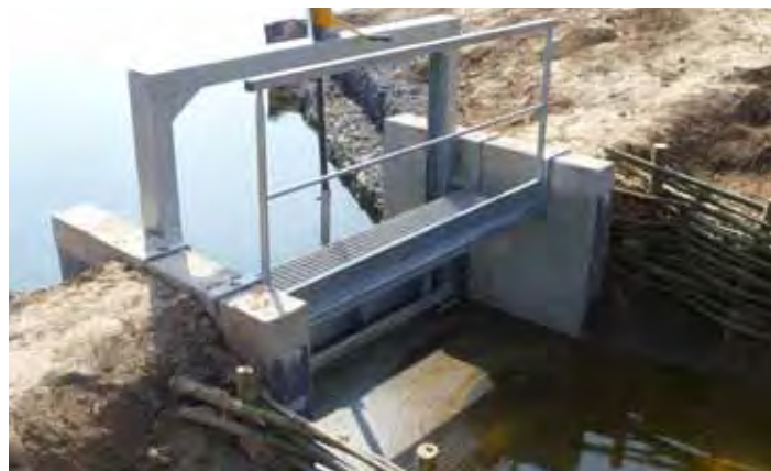
Mise en place de deux connexions hydrauliques entre la Scarpe canalisée et la frayère aménagée. Dispositif permettant la gestion des niveaux d'eau de la frayère
