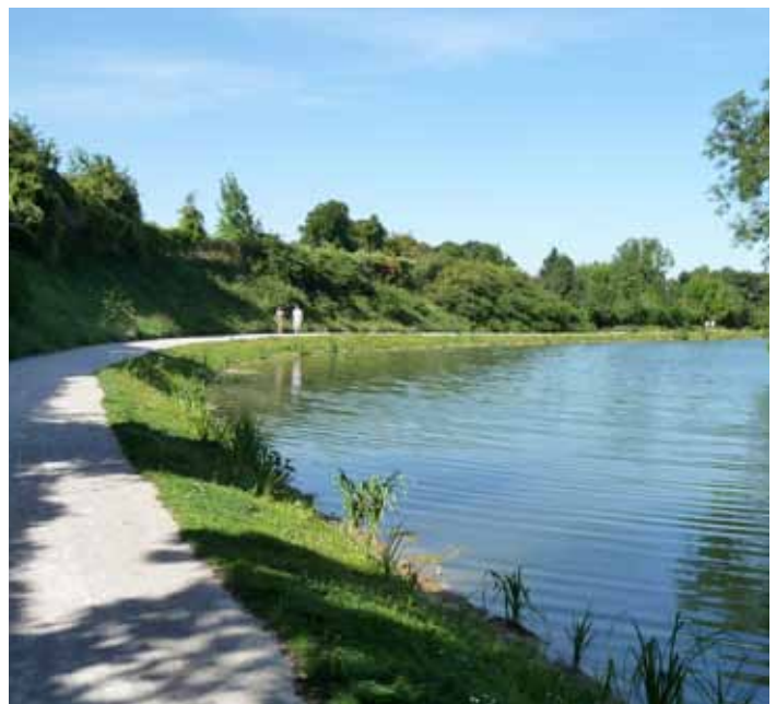
Avant, pendant et après travaux (berges végétalisées)
