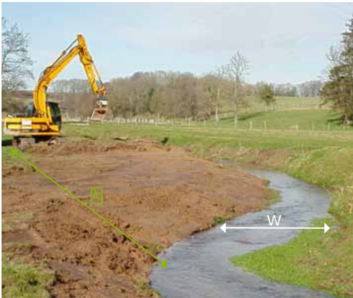
Reprofilage des berges et reméandrage du lit mineur (Crédit photo : AMEVA)
