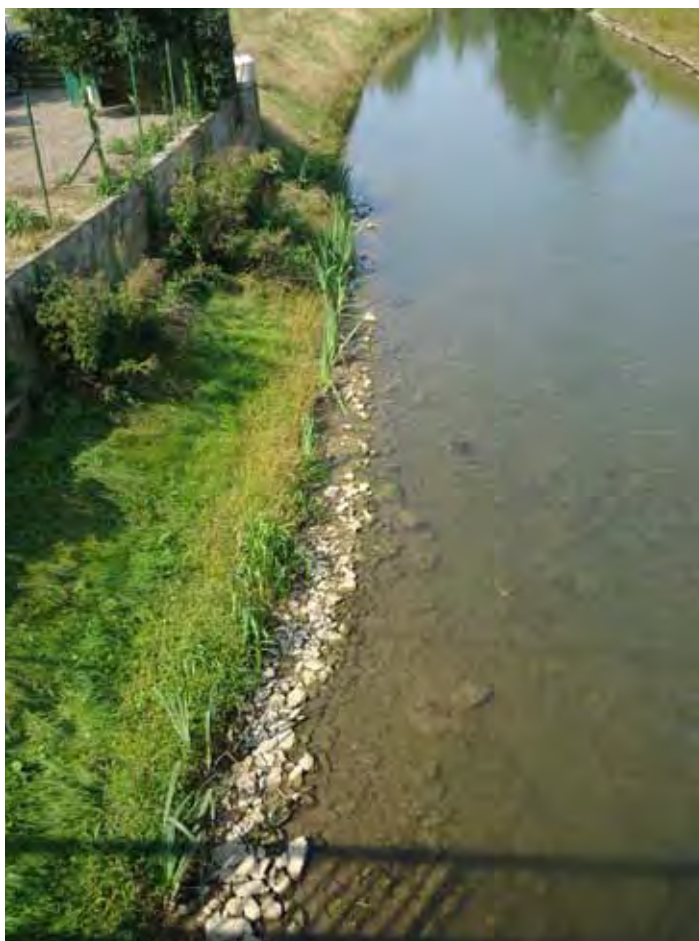
Berges en techniques végétales (2012 AEAP)
