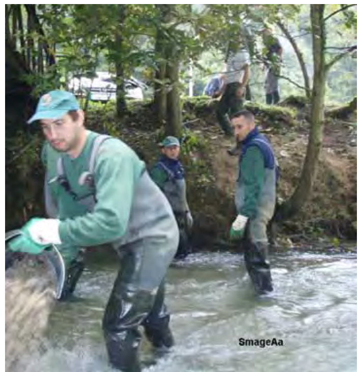
Mise en place des graviers 20-40 mm
