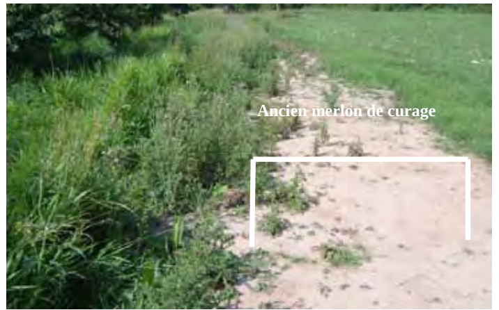
Arasement de l'ancien merlon de curage
