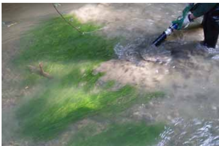
Décolmatage des graviers à la motopompe et au croc
