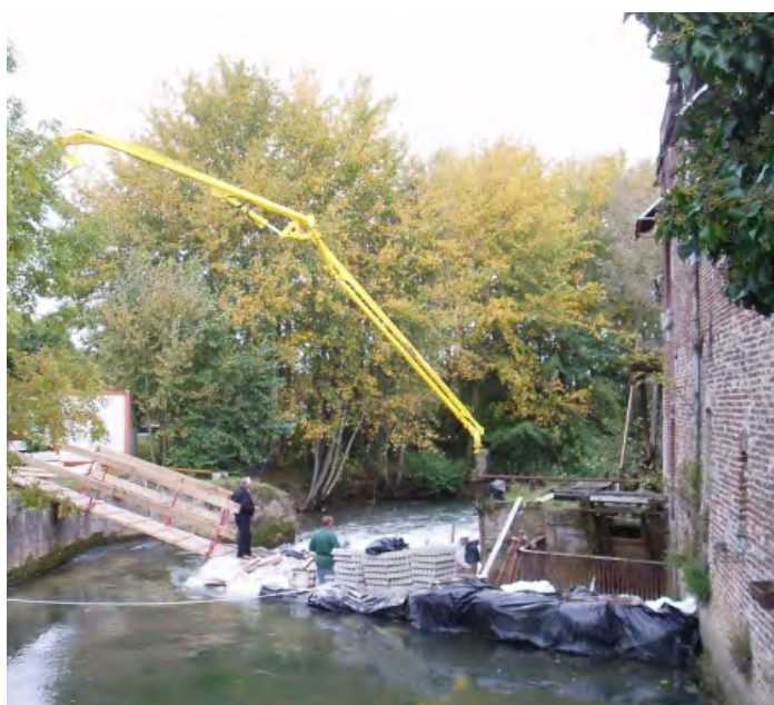
Travaux de maçonnerie (Crédit photo : SmageAa)
