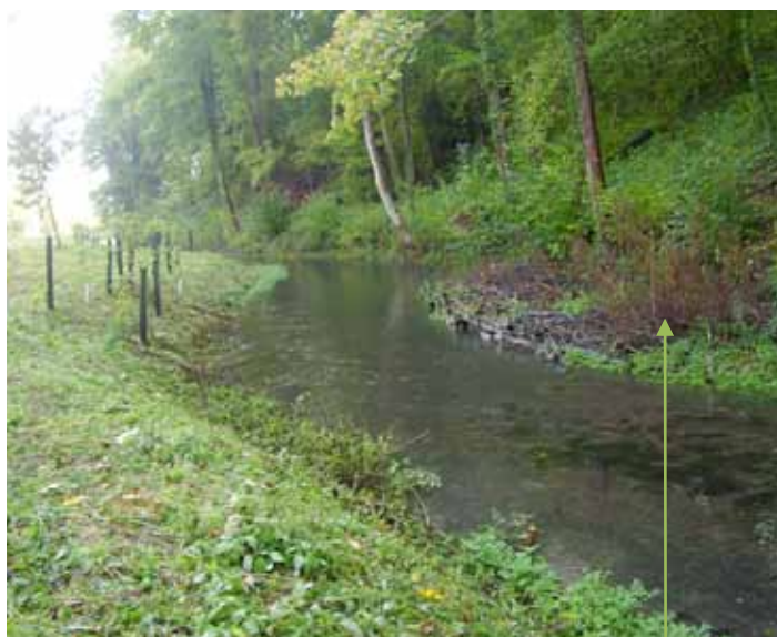
Mise en place de peigne (AEAP)
