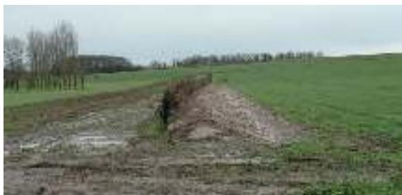
*Association d'un ouvrage de régulation (talus) et d'un aménagement d'hydraulique douce (fascine) sur la Communauté de Communes du Montreuillois*
